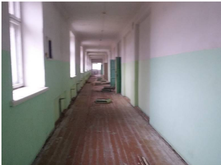
Рис. АС-22 Общий вид коридора второго этажа
