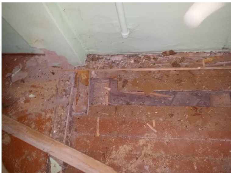
Рис. АС-21 Результат вскрытия полов второго этажа
