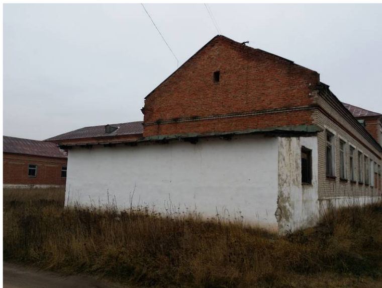
Рис. АС-9 В осях 1-2/Г выполнен пристрой
