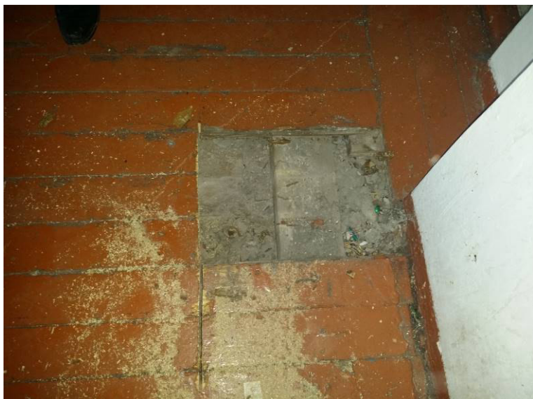
Рис. АС-26 Результат вскрытия перекрытия второго этажа.
